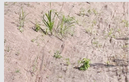
3 Cubierta de fibra de coco para la estabilización del suelo
