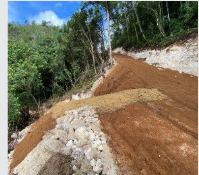
Medidas de control de la erosión tras la recuperación de las piezas de la Torre 4
