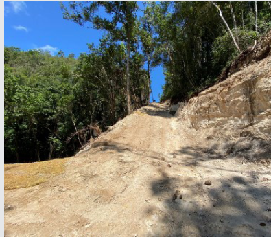
Camino de acceso temporero en la Torre 4
