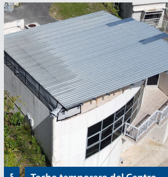
5 Techo temporero del Centro de Aprendizaje
