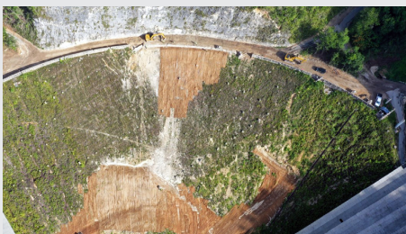
2 Reparaciones del muro de concreto del borde y medidas de control de la erosión
